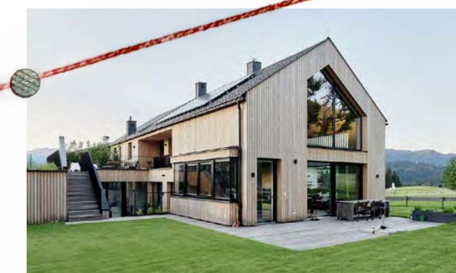
Innovatives Holzbau-Bauprojekt in Schwendt – konnte von der Bodenplatte bis zum Dachstuhl in 8 Monaten Bauzeit umgesetzt werden.
